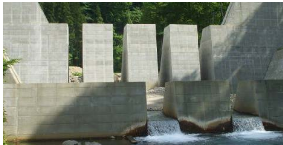
須川第 2 砂防堰堤
