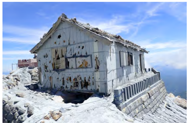
図 2 御嶽山 2014 年噴火で噴石の被害を受けた頂上の御嶽神社社務所。御嶽山合同観測班地質班撮影。
